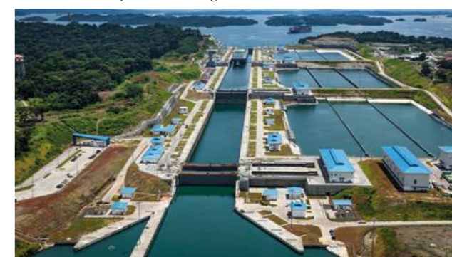
Canal de Panam Ampliado Esclusas Agua Clara
